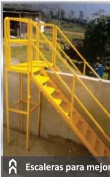
Reparación Filtro Biocombustible
